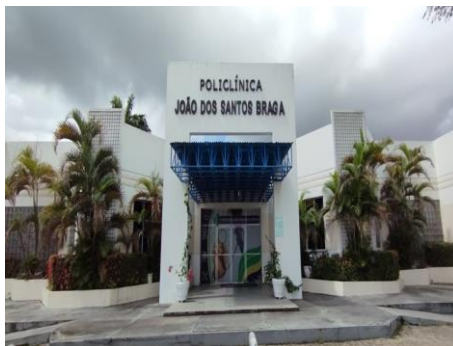
Fachada da Unidade
